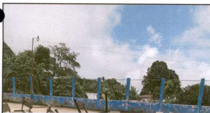
Sustitución de Barandas de Metal
