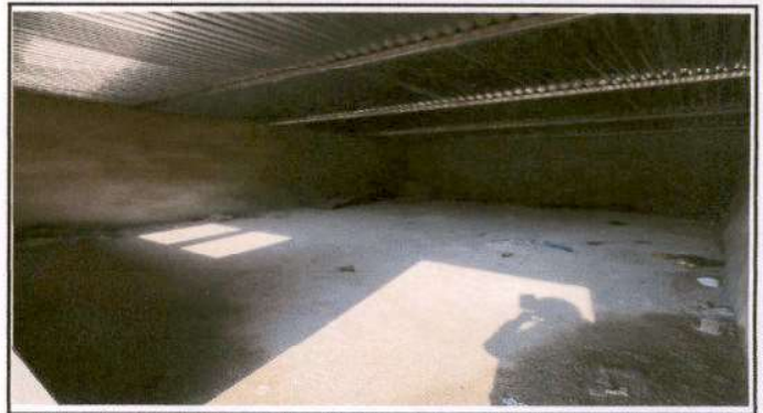
Instalación de unidades de luz, (incluye interruptor, ducto y cable eléctrico)
