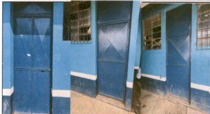
Mantenimiento a estructura (Lijado, cambio de tubo, cepillado, sujeciones aplicación de Pintura) y sustitución de Chapa
