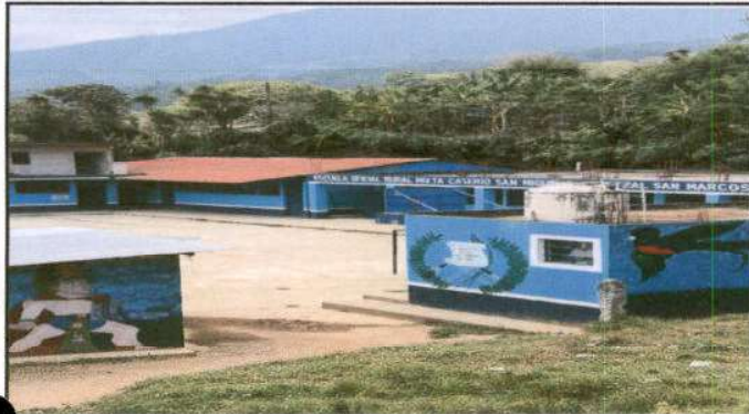
Fabricación e instalación de portón de ingreso
